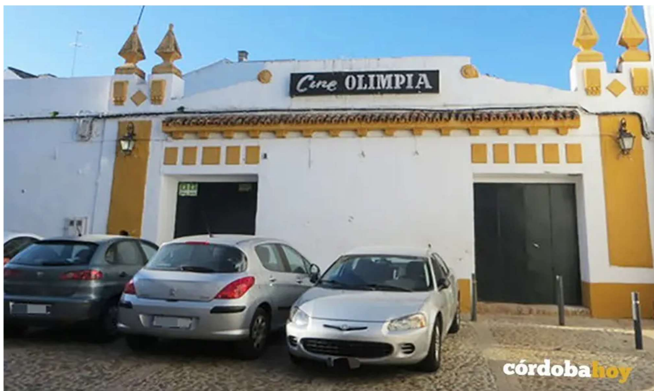
Fachada del Cine Olimpia en el ensanchamiento de la calle Zarco
