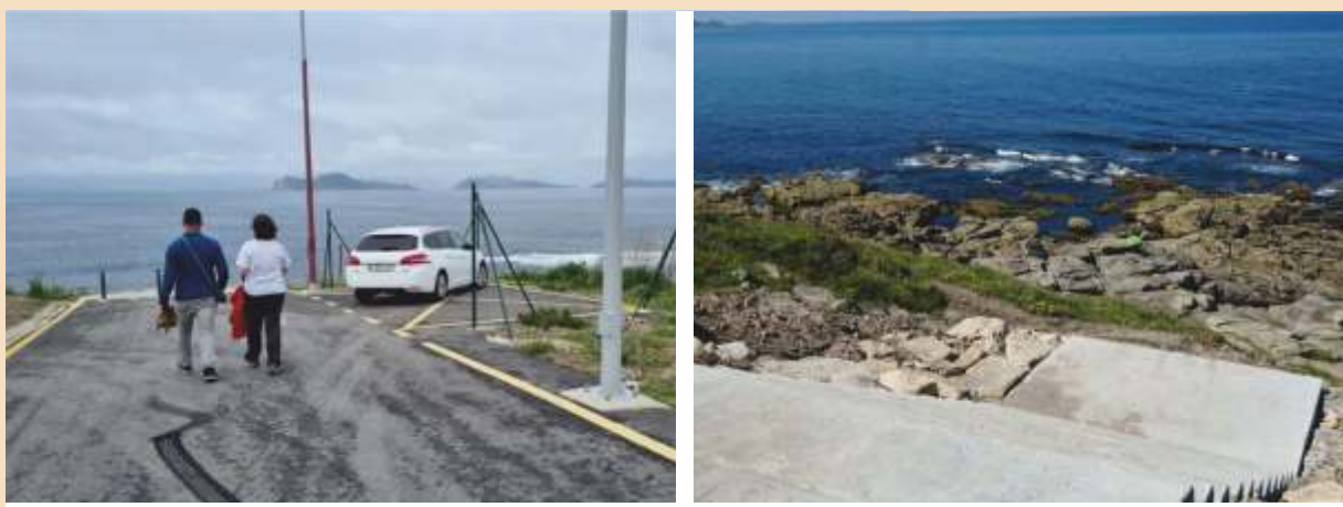
Accesos a los chalés construidos en Dominio Público Marítimo-Terrestre.
