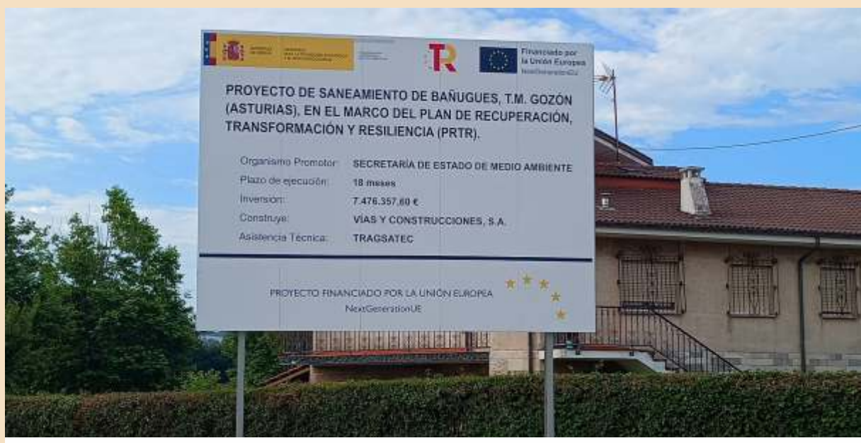
Cartel anunciando la actuación de saneamiento en Bañugues.
