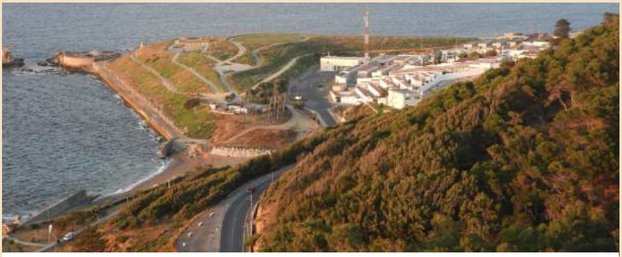
Las instalaciones de la EDAR deben modernizarse y actualizarse.
