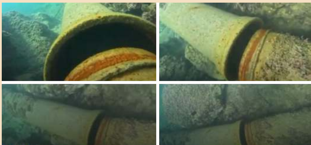
Rotura en el aliviadero del Cabo de la Huerta. Fuente: Diario Información. Publicada el 10 Mayo 2026.
