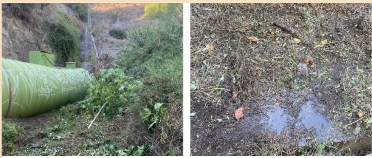
Vertidos de aguas residuales del camping.
