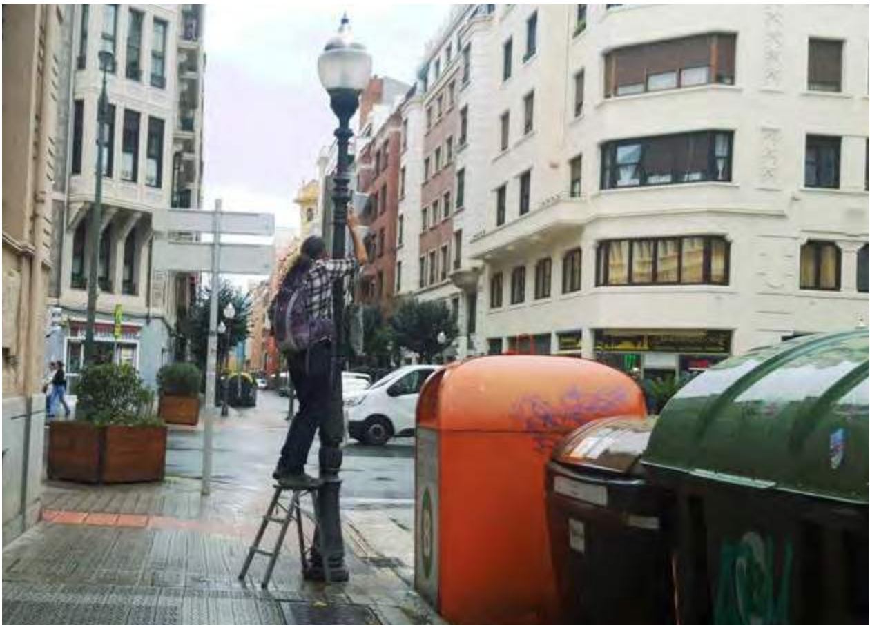
Figura 19: Colocación de tubo en calle Juan Ajuriaguerra con Avenida Rekalde
