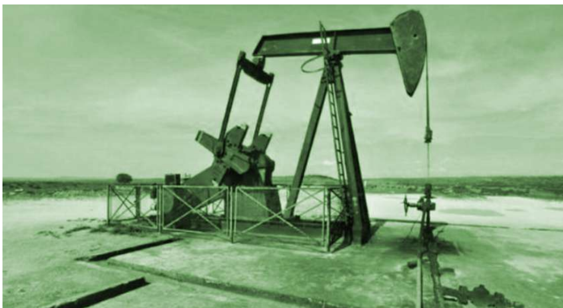
Imagen: Pozo petrolífero de Ayoluengo, en Burgos.
