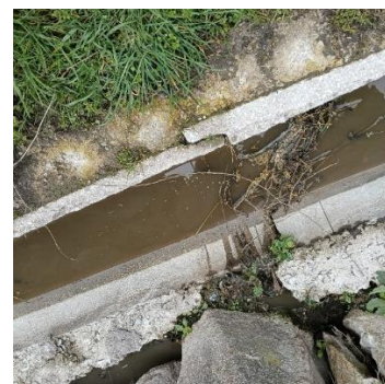
Canalización de lixiviados en exterior de las instalaciones. Camino del Molino de las Viñas
