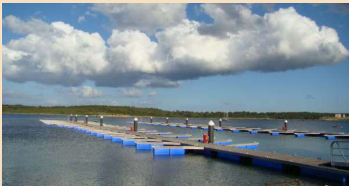
Instalación de nuevos pantalanes flotantes en la ampliación del puerto de Fornells.
