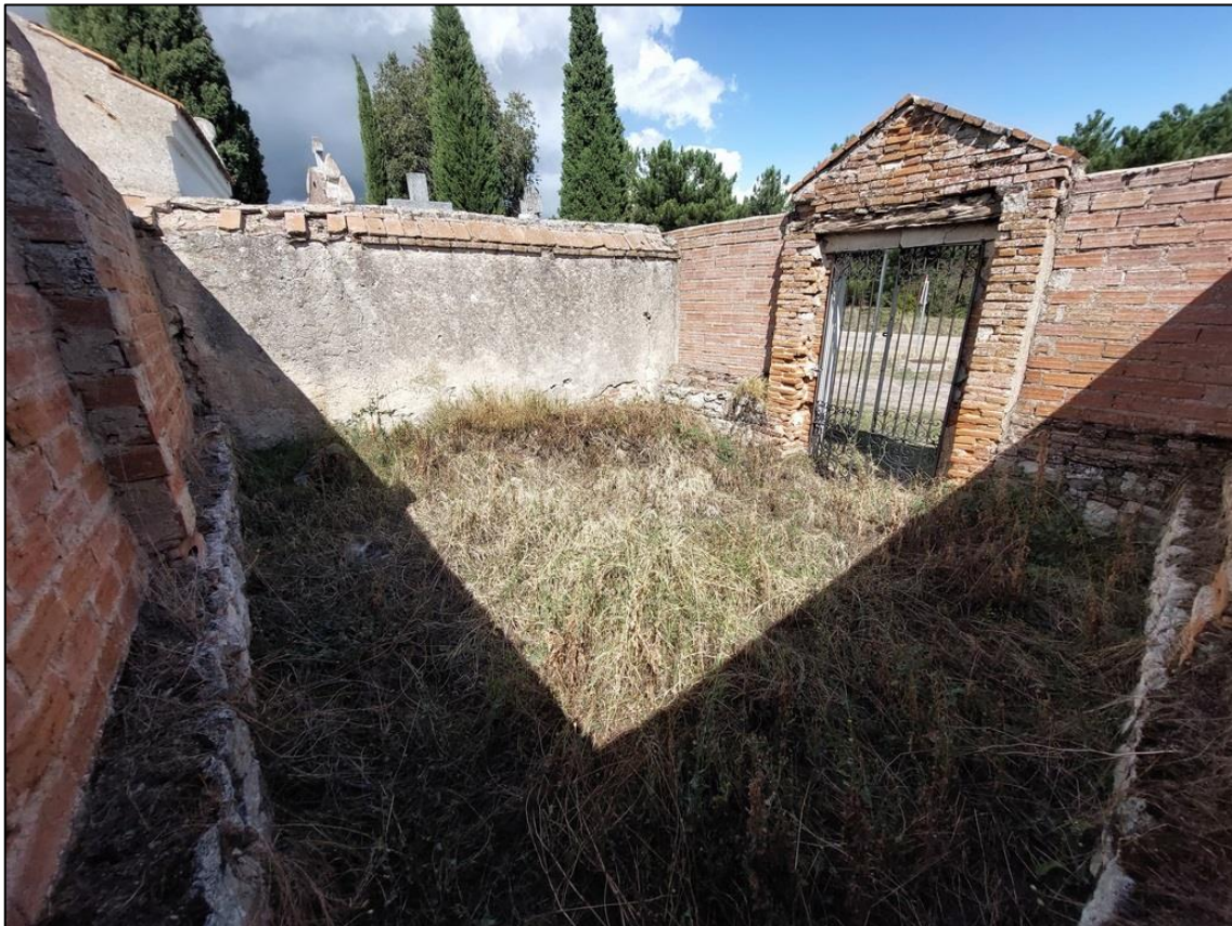
Vista del estado actual del terreno a intervenir. Visita el 17 de septiembre de 2023.
