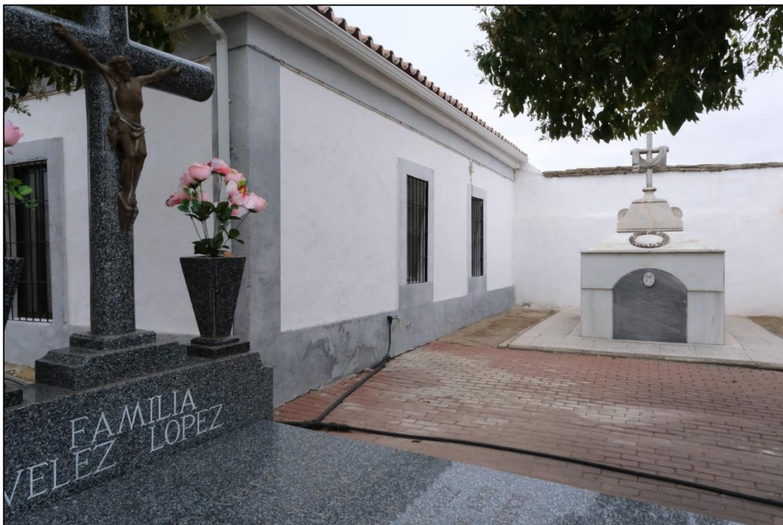
Parte derecha de la capilla. En la misma zona panteón de la familia Cárdenas y Morillo. Vista SO-NE.
