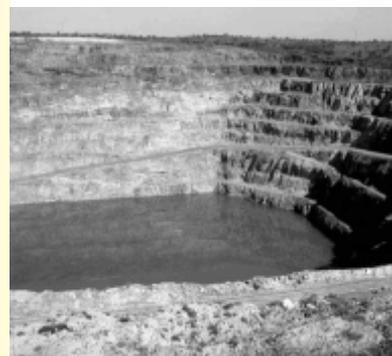
*En la corta de viertieron miles de toneladas de tierras y lodos procedentes de escombreras que se estan desmantelando en la zona, así como los materiales de los movimientos de tierra originados por la implantación de ciertas industrias sobre suelo contaminado (futura Planta de Biodiesel, etc...). Esto puede provocar una alarmante subida del nivel de sus aguas contaminadas (incluso por encima de la cota 0).*
